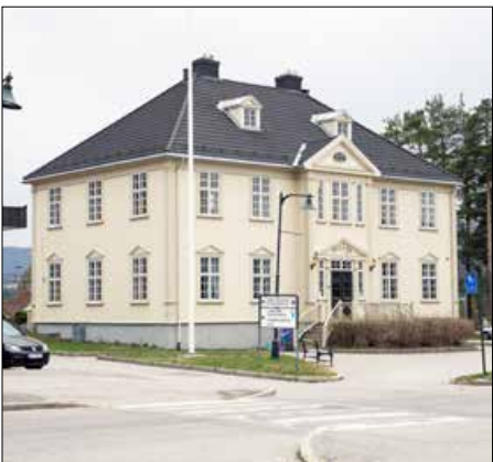
Gamlebanken i Lunde er et av flere bygg som trenger vedlikehold.
